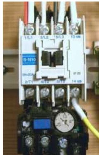
※電磁接触器 上白 ※サーマルリレー 下黒
